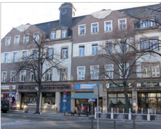
■ Wohn- und Geschäftshaus Hauptstraße 11 vor der Sanierung
