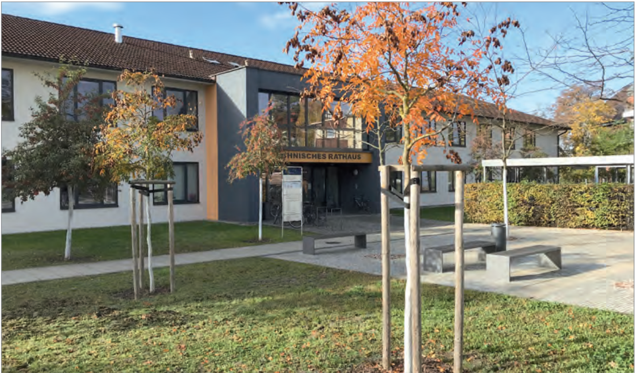
Die größte Veränderung am Technischen Rathaus erfolgte im Eingangsbereich. Er wurde deutlich vergrößert, um den Sitzungssaal zu erweitern und dem Gebäude insgesamt ein modernes Aussehen zu verleihen.
