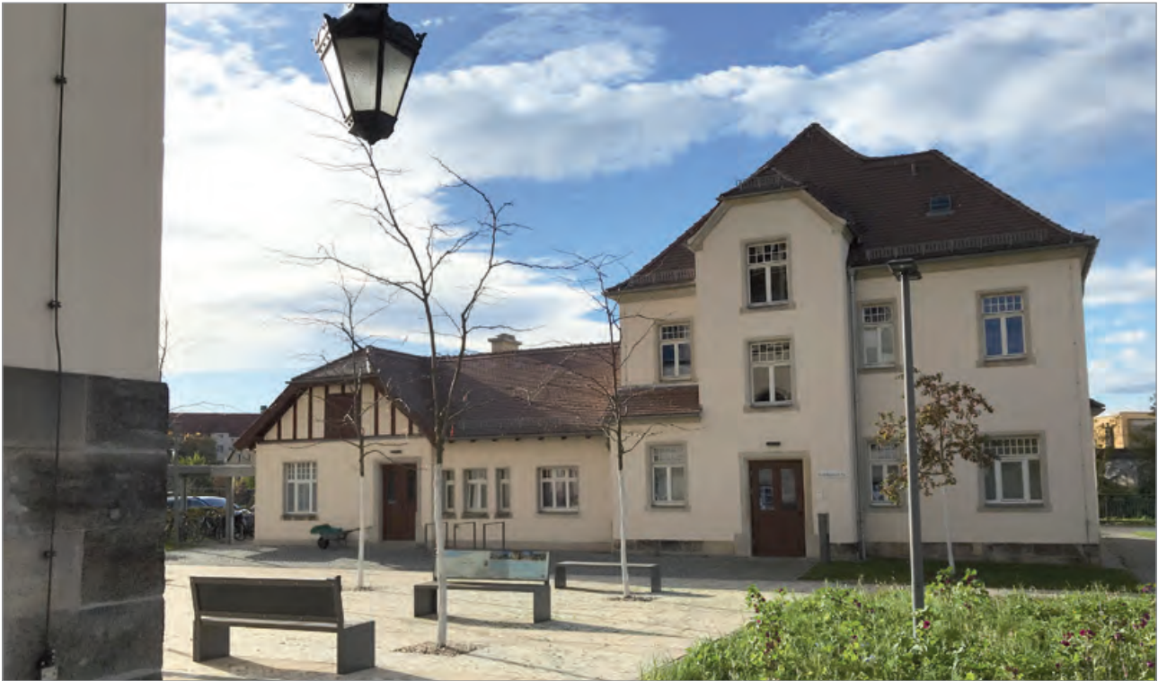
In der alten Polizeiwache sind jetzt ein Blockheizkraftwerk und Büroräume der Beteiligungsgesellschaft Radebeul untergebracht. Seit 2015 erstrahlt das zweigeschossige Gebäude wieder.
