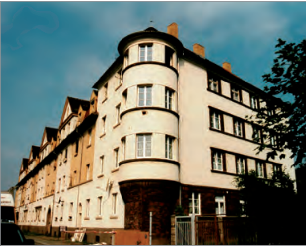
■ Genossenschaftliche Wohnanlage, Teil Mittelstr. 2-10 vor der Sanierung
