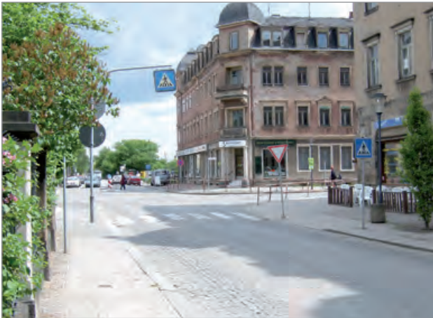
Vor dem Ausbau hatte die Pestalozzistraße eine unebene Fahrbahn und einen stark geneigten schmalen Fußweg.
