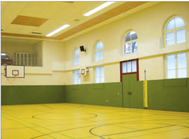
In der Turnhalle wurde eine Prallschutzwand eingebaut und der Fußboden mit einem neuen Belag versehen.
