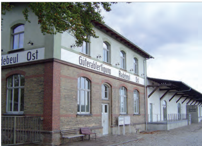
Das Gebäude, in dem früher Güter der Schmalsspurbahn umgeschlagen wurden, beherbergt heute Schmalsspurbahnmuseum und Eventlocation.
