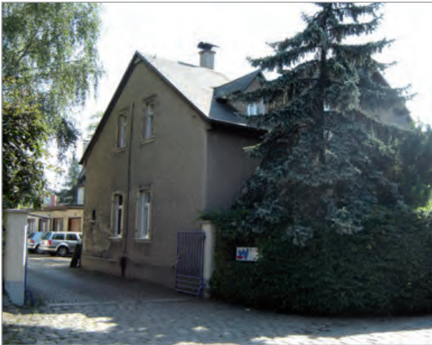
■ Einfamilienhaus Sidonienstraße 7 vor der Sanierung
