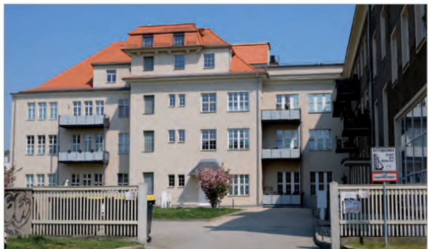
2013 wurde das AWD-Laborgebäude durch die Ventar Immobilien AG komplett entkernt und in ein Wohnhaus umgewandelt.
