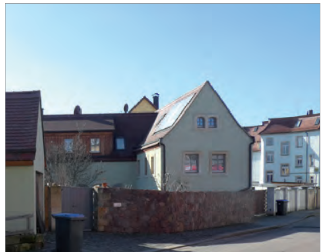
nach der Sanierung
