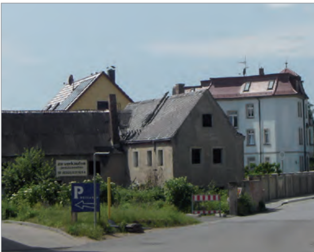
■ Ehem. bäuerliches Anwesen Serkowitz Straße 40 vor der Sanierung
