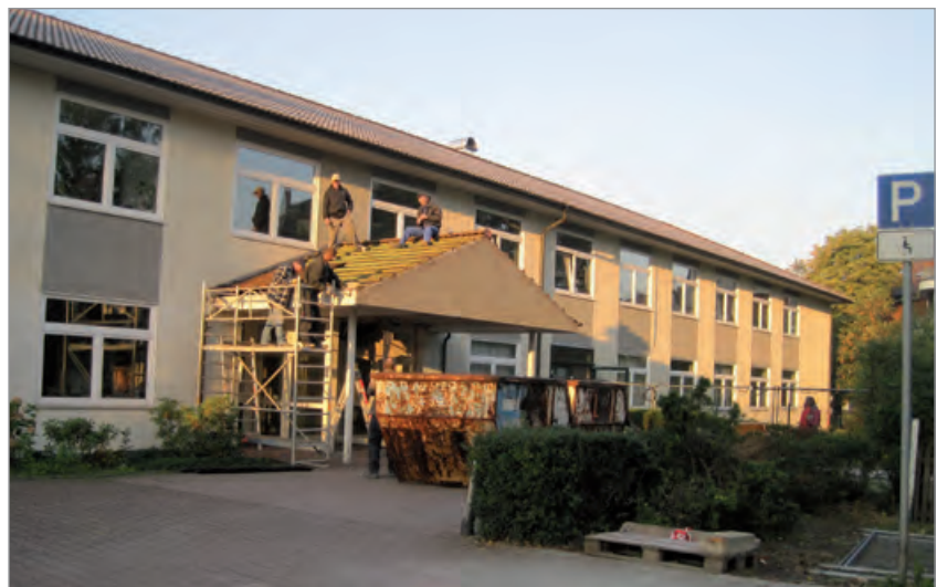
2015 begann der Umbau des Technischen Rathauses.
