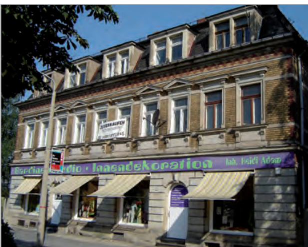
■ Wohn- und Geschäftshaus Robert-Werner-Platz 6 vor der Sanierung
