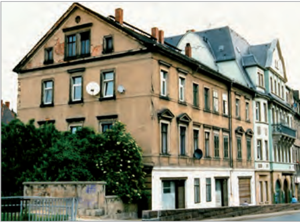
Die Hauptstraße 4 war ein sanierungsbedürftiger Altbau.
