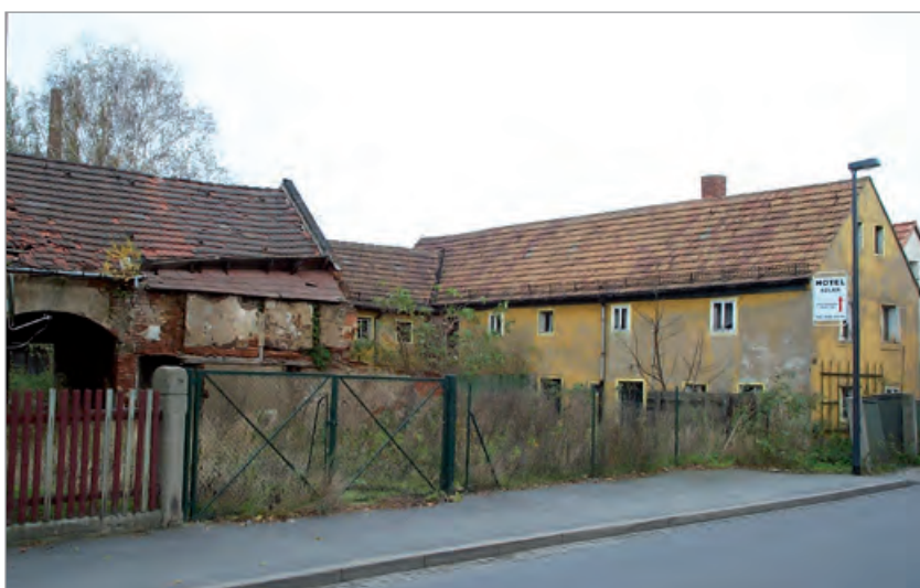
70 Prozent der Gebäude hatten erhebliche Mängel.
