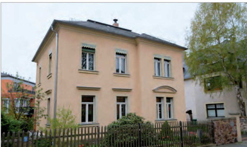
Das Wohnhaus Wichernstraße 3 hat dank Fördermitteln einen freundlichen Fassadenanstrich.
