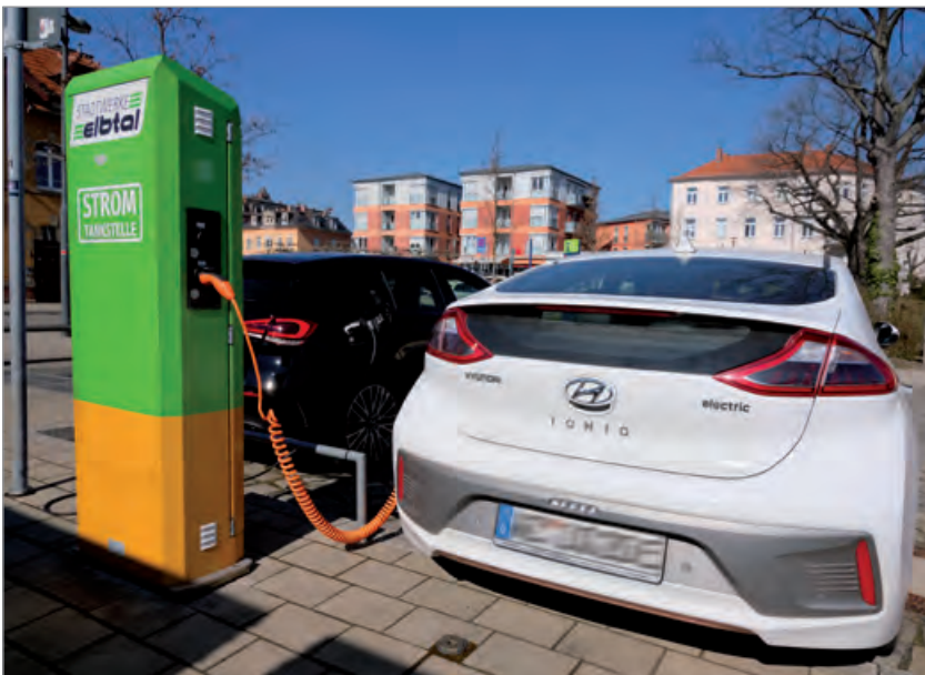
Am Bahnhofsvorplatz entstanden 80 überdachte Fahrradständer für Bike & Ride, Anschlüsse für Elektroautos, eine Car- und eine Bike-Sharing-Station.
