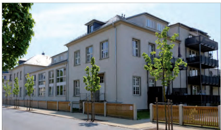
Der ehemalige Gasthof Krone im heutigen Zustand. Das als AWD-Klubhaus bekannte Gebäude ist heute ein Wohnhaus.
