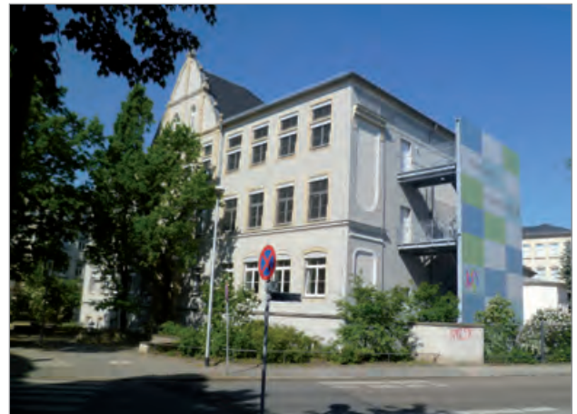
Gesetzliche Vorgaben erforderten den Bau einer zweiten Rettungstreppe. Sie ziert nun das Logo der Grundschule.
