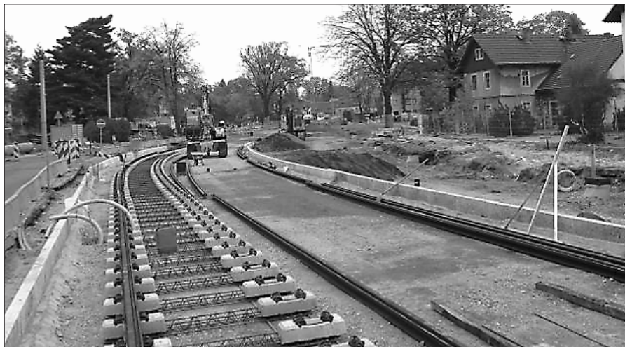
November 2005, Gleisbauarbeiten für die Straßenbahn – landwärtiges Gleis (Richtung Weinböhla), hier neben Moritz-Garte-Steg
