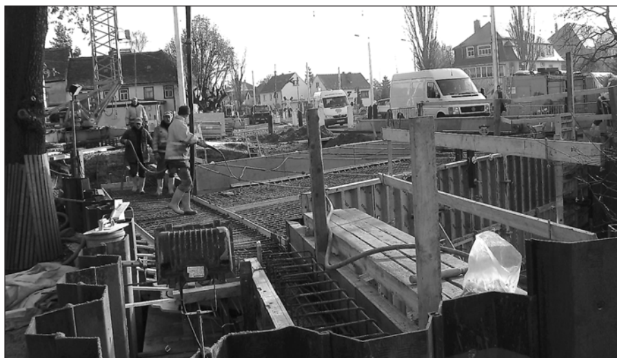
Dezember 2005, Arbeiten an der Nordseite der Lößnitzbachbrücke
