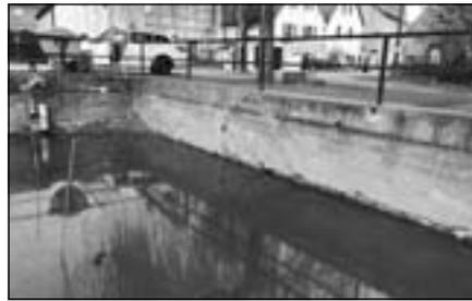
Nachdem im Herbst der Anglerverein Radebeul die Fische in das Löbnitzbad umgesetzt hatte, wurde mit der Entschlammung des Dorfteiches begonnen. Es ist geplant, danach die Ufermauern, insbesondere den Mauerfuß, zu sanieren. Zuletzt wird der Rest des Schlammes entsorgt und die Teichsohle hergestellt. Die Arbeiten werden im Rahmen der Unterhaltungsarbeiten öffentlicher Anlagen von der Fa. NERU Radebeul und der Humuswirtschaft Dresden durchgeführt.
