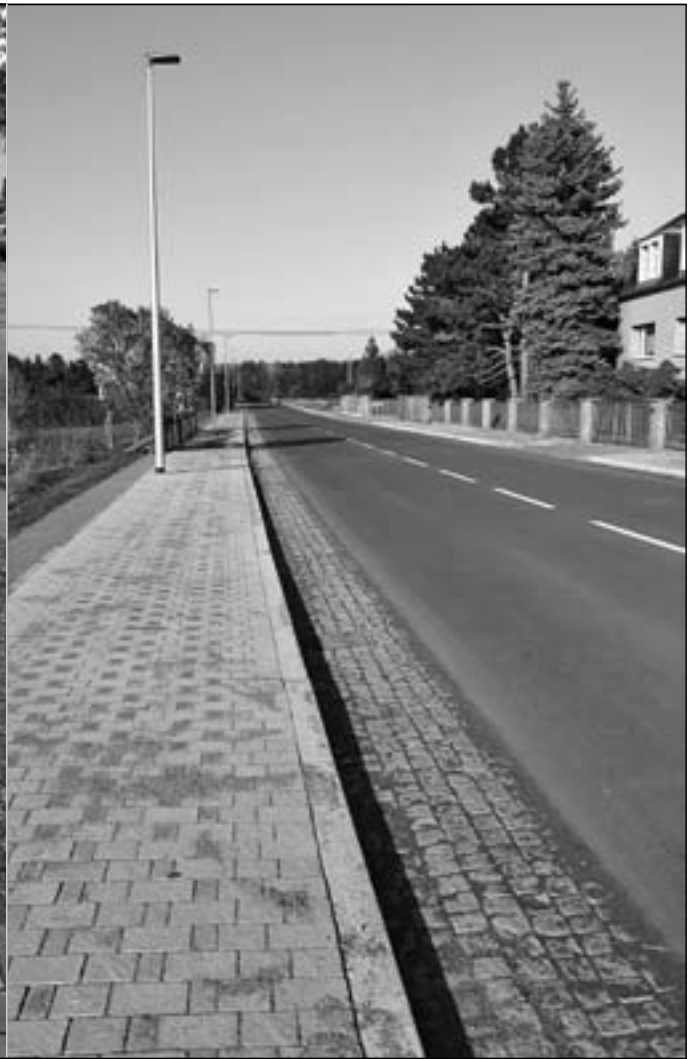
Gehwegbau im Zusammenhang mit Hochwassermaßnahme Instandsetzung Kötzschenbrodaer Straße zwischen Am Gottesacker und Weintraubenstraße
