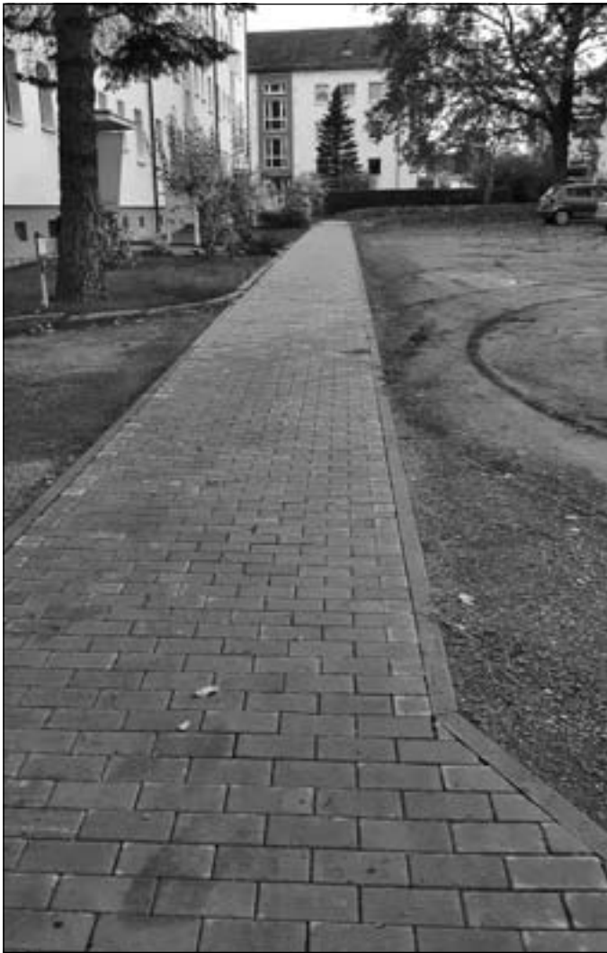
Gehwegabschnitt vor Rudolf-Harbig-Straße in Höhe Nr. 7
