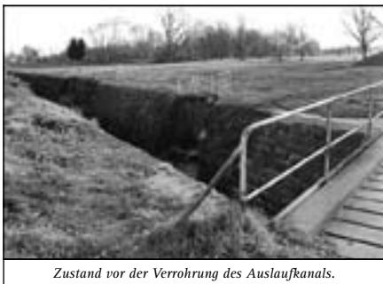
Zustand vor der Verrohrung des Auslaufkanals.
