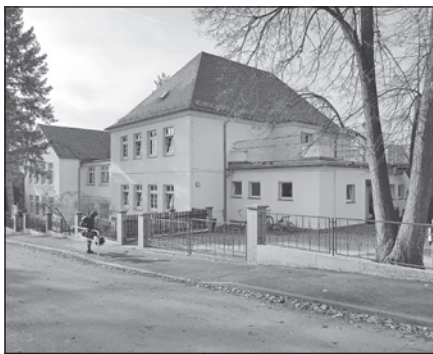
Grundschule Oberlößnitz Umfassende Fassadensanierung inkl. Anstricherneuerung von Juli bis August 2021.
