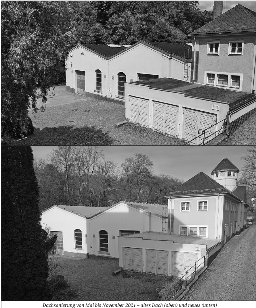
Dachsanierung von Mai bis November 2021 – altes Dach (oben) und neues (unten)
