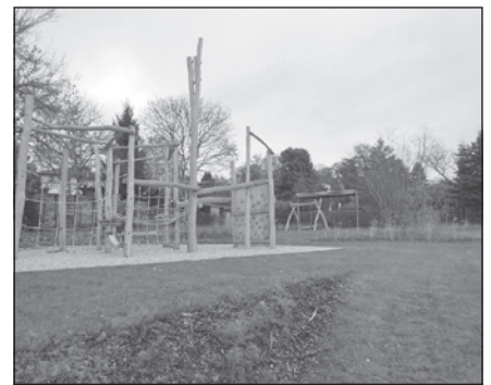
Außengelände Schillerhort Nach gut einem Jahr Bauzeit wurde das Außengelände vom neuerrichteten Schillerhort bis Ende November 2021 fertiggestellt.
