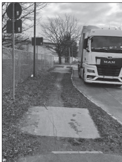
Kötitzer Straße vor der Sanierungsmaßnahme
