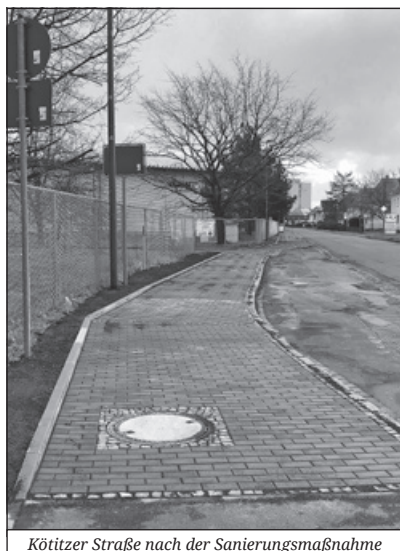
Kötitzer Straße nach der Sanierungsmaßnahme
