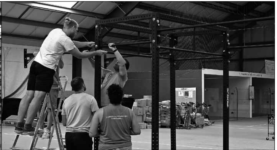
Mitarbeiter der sbf GmbH bauen den Fitness-Bereich auf
