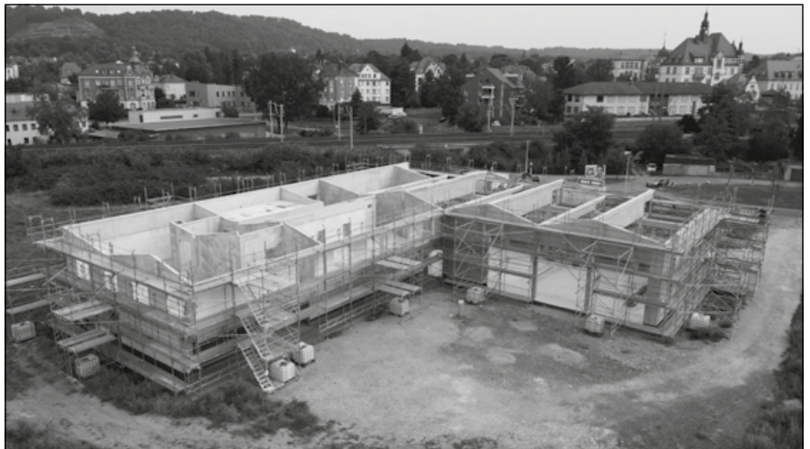
Luftperspektive Rohbau mit Gerüst
