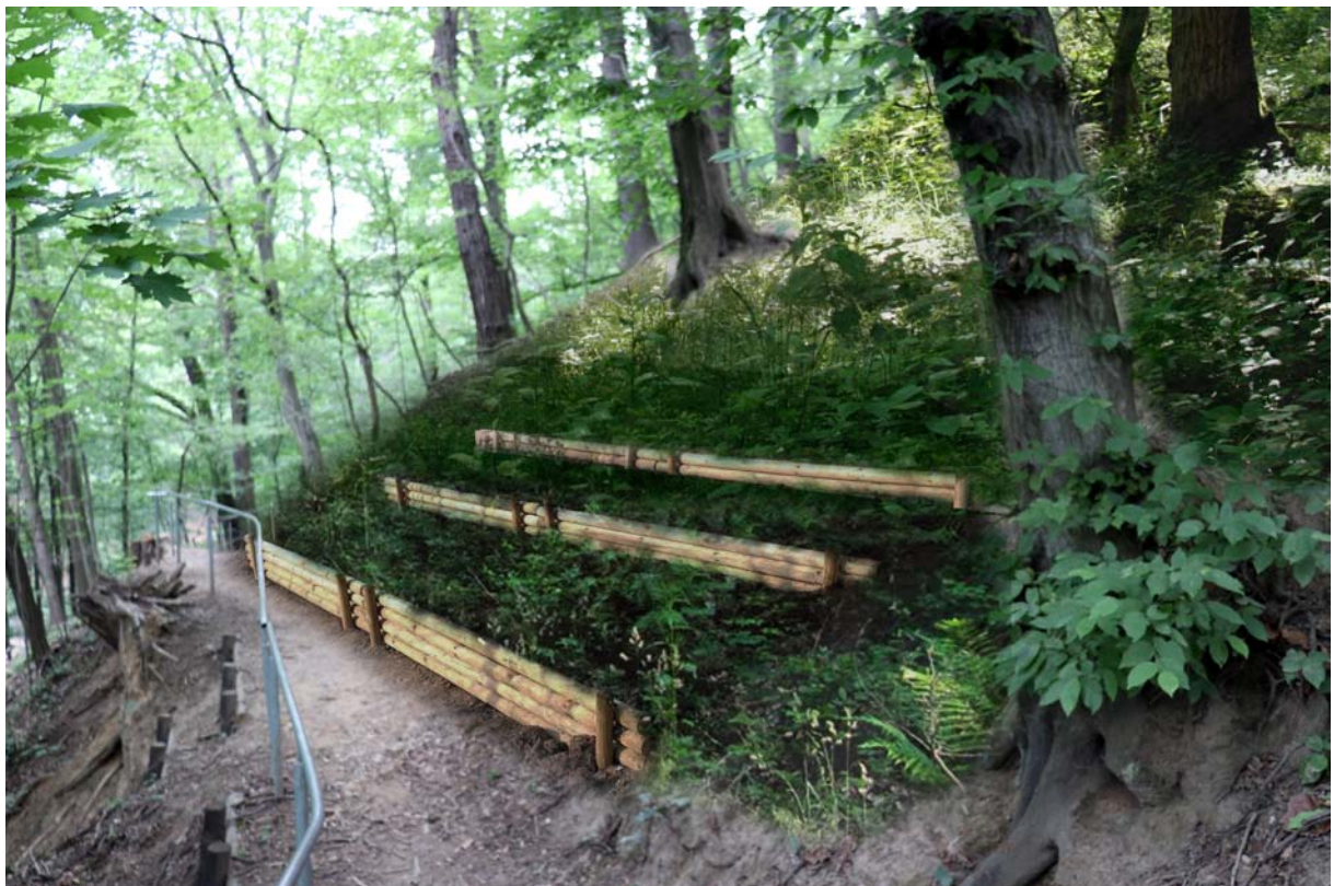
Visualisierung: Hangsicherung mit Holzstämmen
