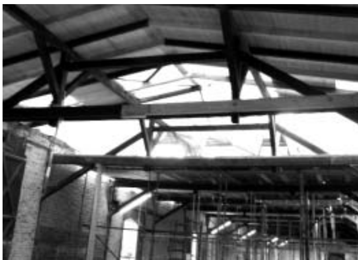
Blick in die künftige Ausstellungshalle.
