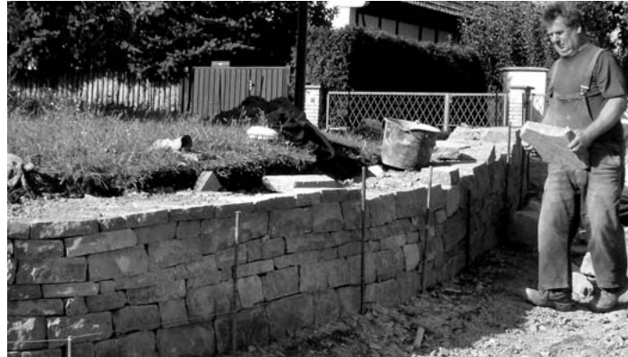
Mitarbeiter der Baufirma STR Radebeul beim Bau der Trockenmauern
