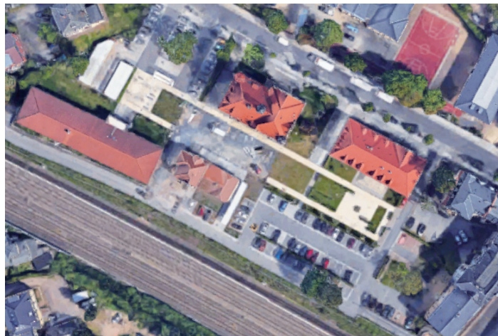
Nachher: Noch nicht ganz fertig, aber bereits sehr gut auf dem Luftbild zu erkennen, ist das neu gestaltete Rathausgelände mit dem Hochzeitsgarten.
