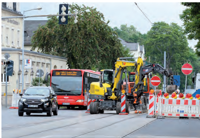
Die Baustellen erforderten einseitige Straßensperrungen.
