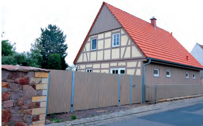
Straßenansicht Serkowitzer Straße 16
