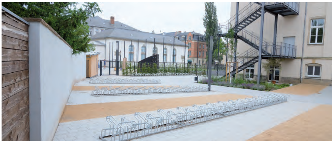
Bis auf den Sportplatz ist der Umbau der Schulhöfe abgeschlossen.
