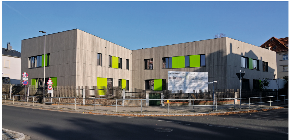
An der Kreuzung Schildenstraße/Pestalozzistraße nimmt der neue Schillerhort immer mehr Form an.
