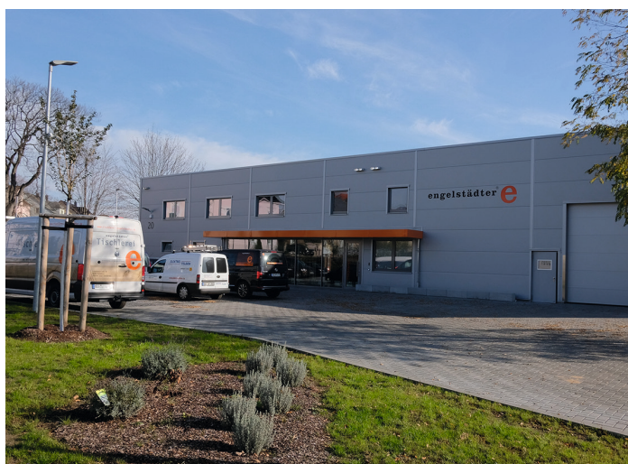
Im Frühsommer 2020 hat die Firma Engelstädter ihren neuen Sitz auf der Sidonienstraße bezogen.
