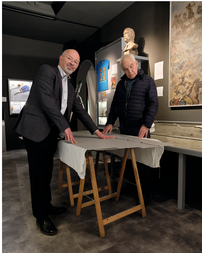
Dr. Volkmar Kunze (l.) hat im neu gestalteten Custer-Raum mit Hand angelegt. Gemeinsam mit Mitarbeiter Rolf Raubach verlegte er beispielsweise neuen Vinylboden.
