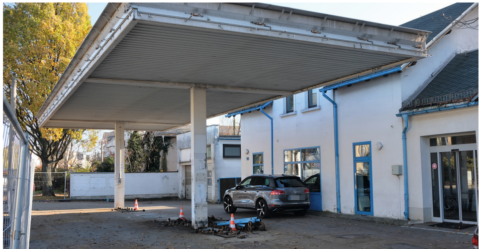
Ende 2021 wird das gesamte Gelände der Aral-Tankstelle beräumt sein.
