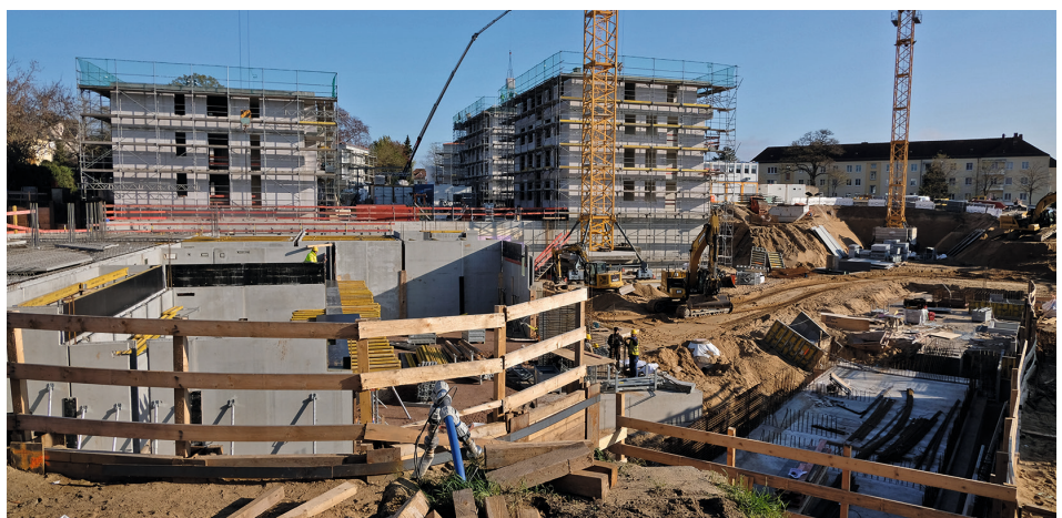
Die Villen des neuen Wohnparks sind im Rohbau fertig.
