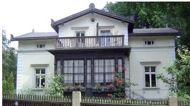
Eine der von Ziller erbauten Villen in Radebeul
