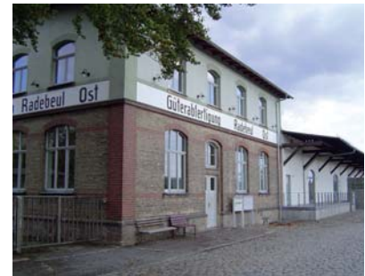
Ehemaliges Verwaltungs- u. Lagergebäude
