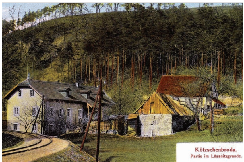
Trassierung der Schmalspurbahn durch den engen Lößnitzgrund
