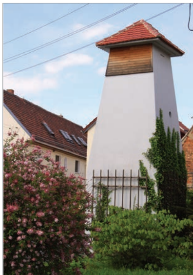
Als Fledermausquartier umgebautes ehemaliges Trafo-Haus
