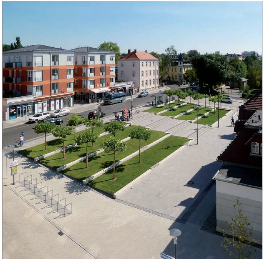
Der an der Sidonienstraße gelegene, terrassierte und begrünte Bahnhofsvorplatz ist Umstiegs- und städtischer Treffpunkt.
